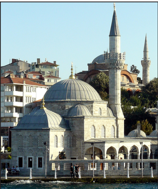
Şemsi Paşa Camii'nin denizden görünümü.
